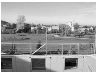
Verein Mehrgenerationenhaus (Verein mgh): 150 Wohneinheiten in Holzbau im Minergie-P-Eco-Standard.
