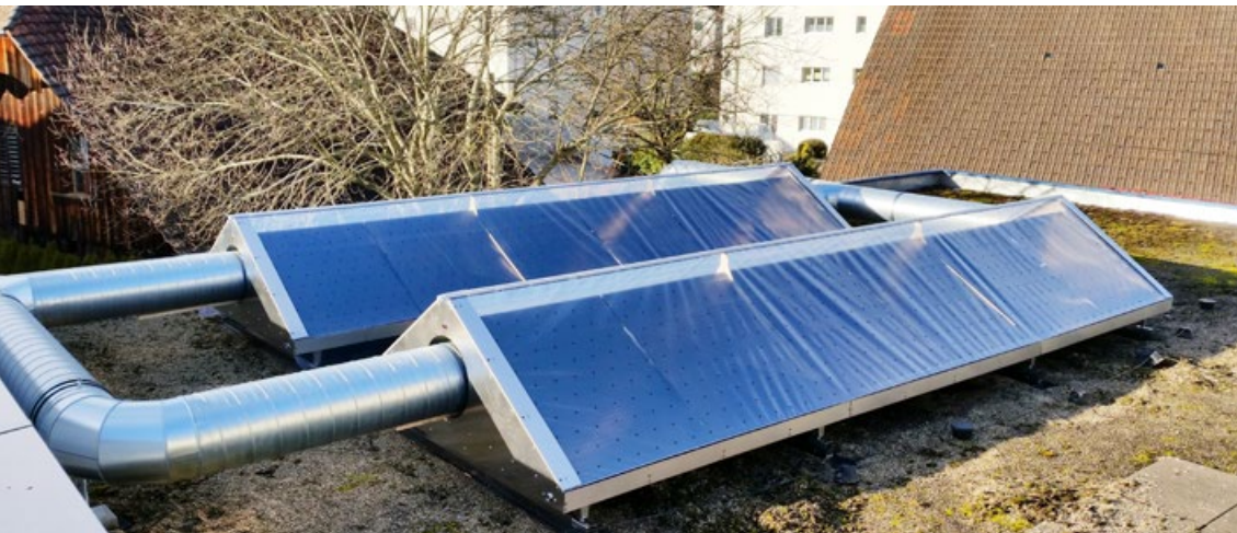
Die Sonne wärmt die Luft vor und spart CO 2 ein beim Heizen oder Trocknen.
