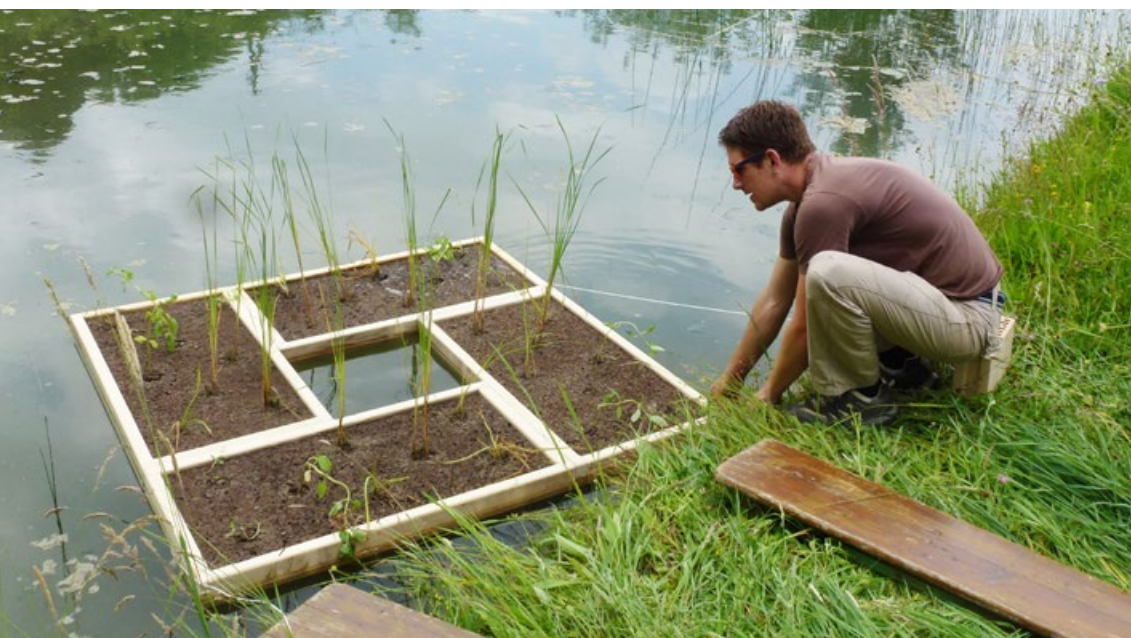
Die bepflanzte Schwimmplattform reinigt das Wasser.
